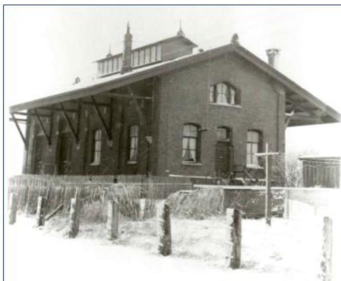
Verlaadstation met kantoor in Scharwoude
